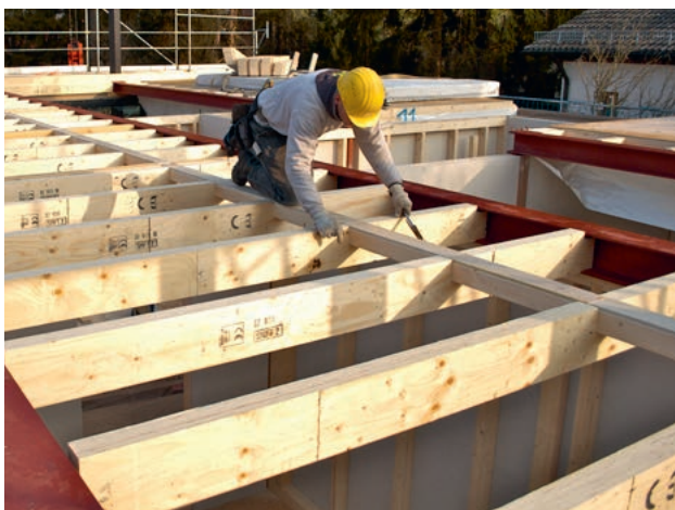
STEICO LVL R bei der Konstruktion von Deckenträgern.
